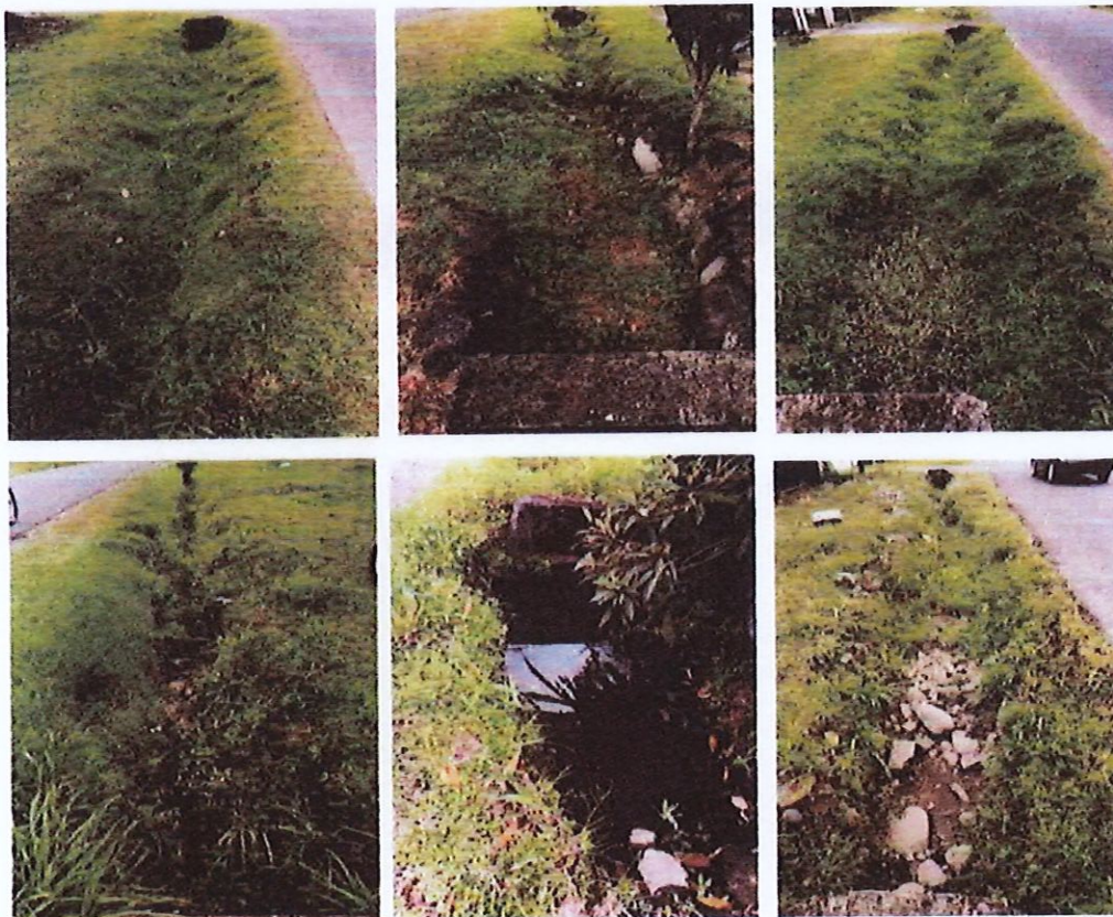
Alcantarillas sobre calle principal desde la Platanera hasta Los Helechos, fotos del 09/01/22.
