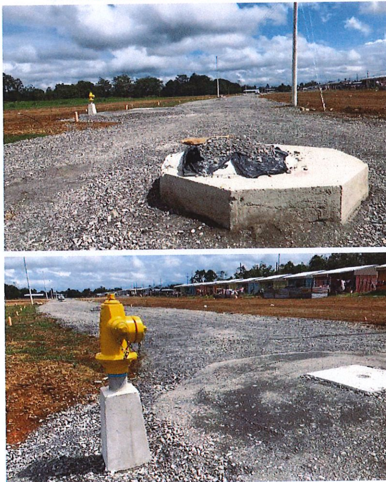
Figura 1.- Inspección de Obras de Infraestructura – Proyecto Astúa Pirie
