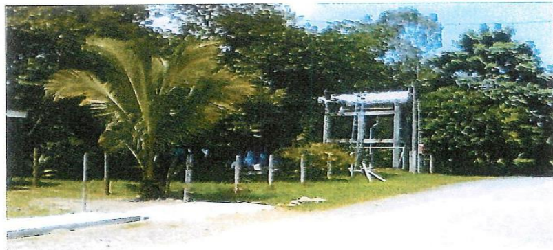
Lote pozo de agua potable
