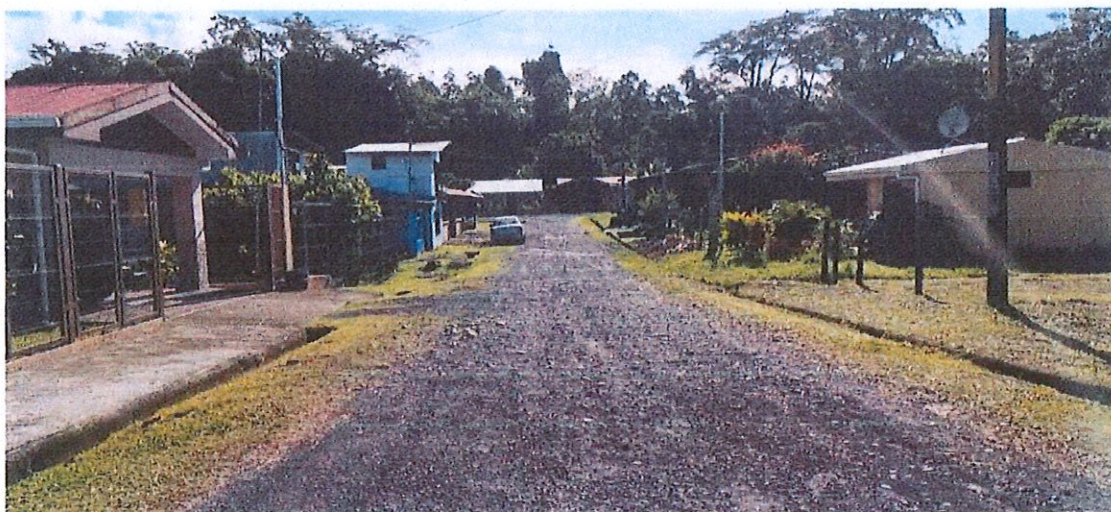
Figura 16. Fotografía a la mitad de la calle B (vista hacia el este).
