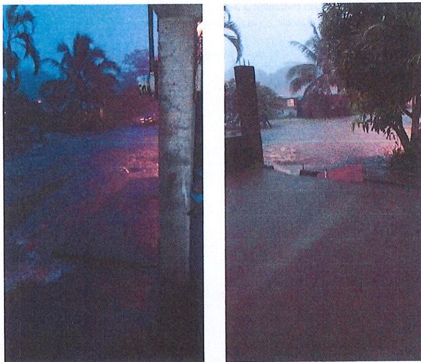
Figura 2. Inundaciones en calle A en diciembre de 2016. Fotos tomadas por el vecino Gustavo Sandoval.
