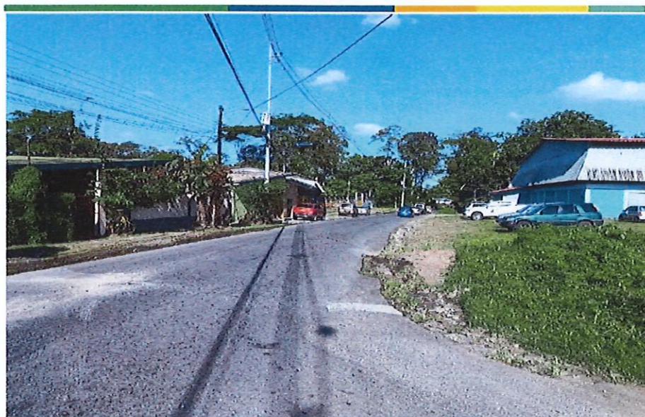
Fuente Obra Pública. Imagen 3
