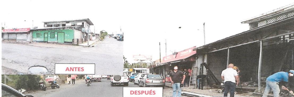
Fotografía #12; demolición y construcción de pared nueva frente calle publica costado norte, jueves 18 de abril (semana Santa | Municipalidad e identidades reguladoras cerradas)
