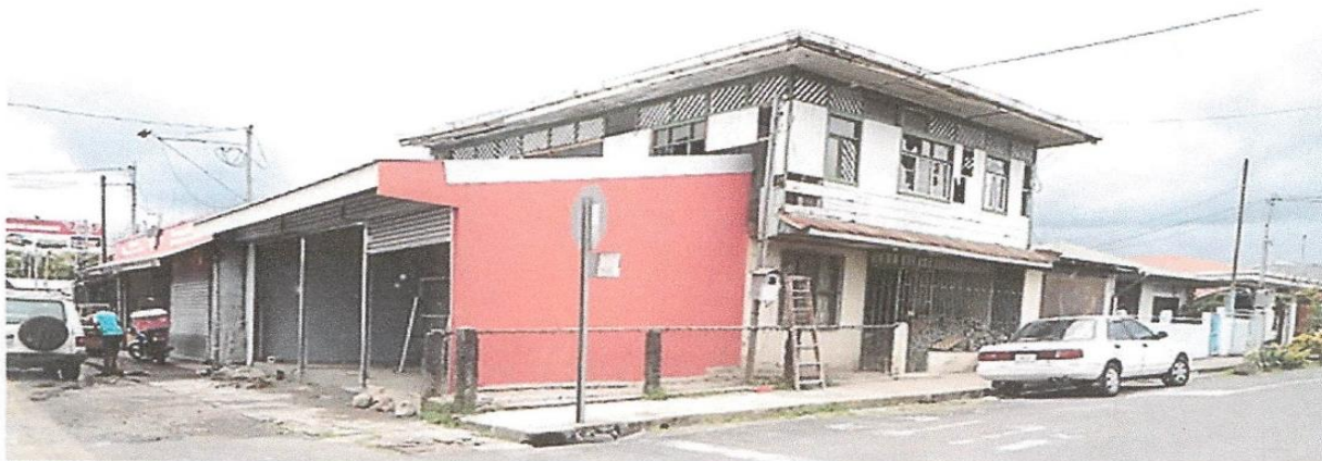
Fotografía #13; instalación finalizada de cortinas metálicas, pintura interior y exterior, precinta, botaguas arreglos en el medidor de electricidad y alimentación eléctrica (instalación eléctrica) del edificio, viernes 19 de abril (semana Santa | Municipalidad e identidades reguladoras cerradas)
