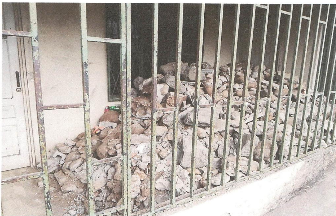
Fotografía #2; escombros, demolición, y construcción de pared costado oeste frente calle pública, viernes 12 de abril
