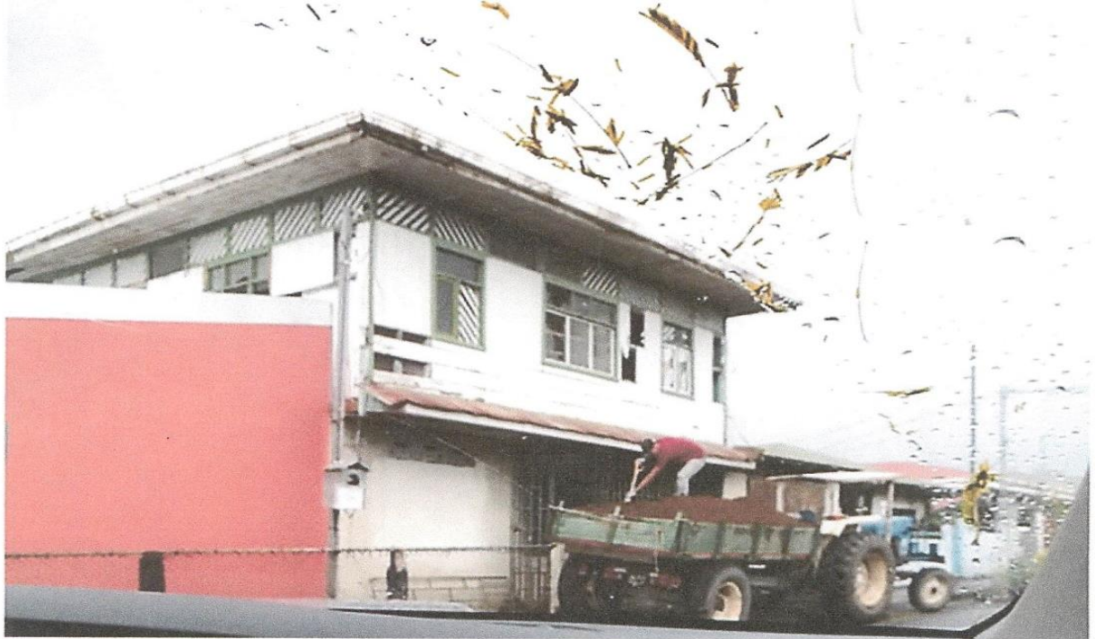
Fotografía #19; entrega de material de relleno tipo lastre o tierra. Reconstrucción en el interior del edificio a puerta cerrada continúa en desarrollo, martes 07 de mayo
