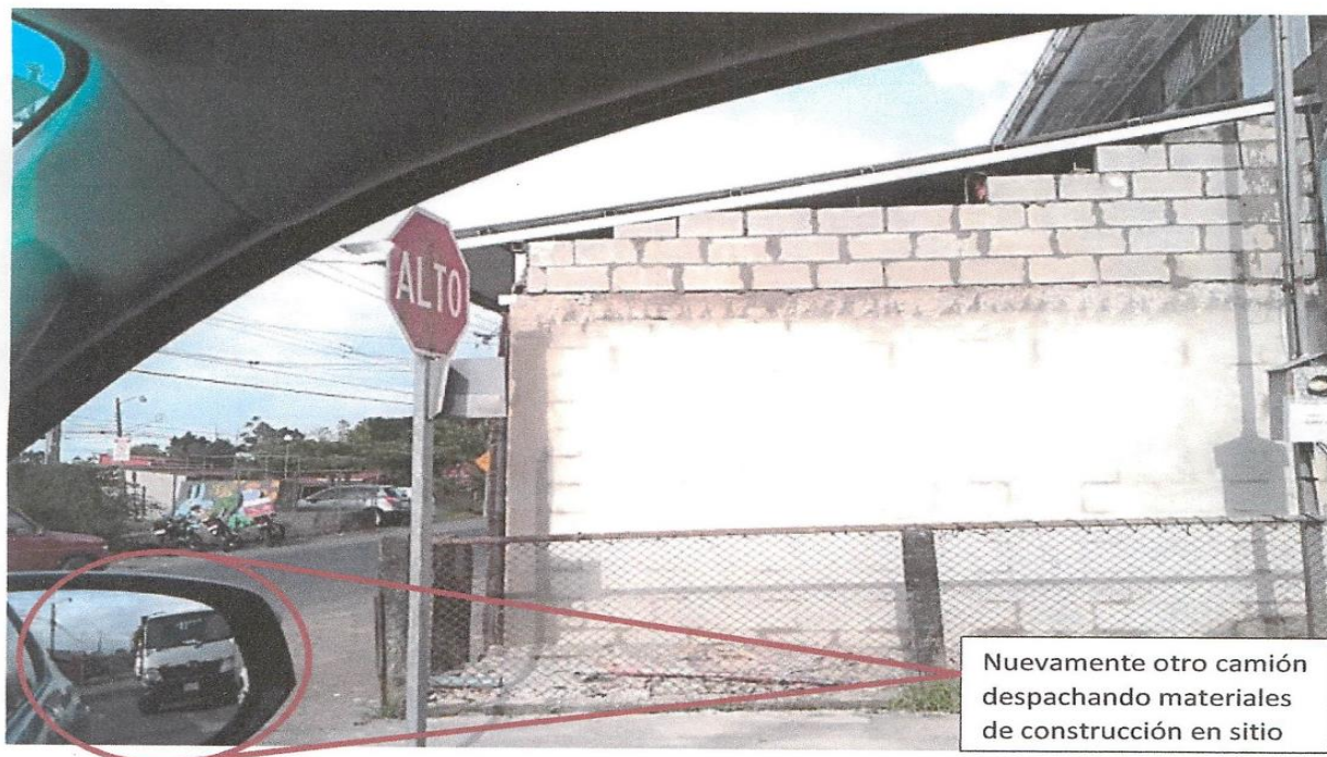
Fotografía #8; pared nueva costado oeste finalizada frente calle publica e inicio de tapichel en block, martes 16 de abril (semana Santa | Municipalidad e identidades reguladoras cerradas)
