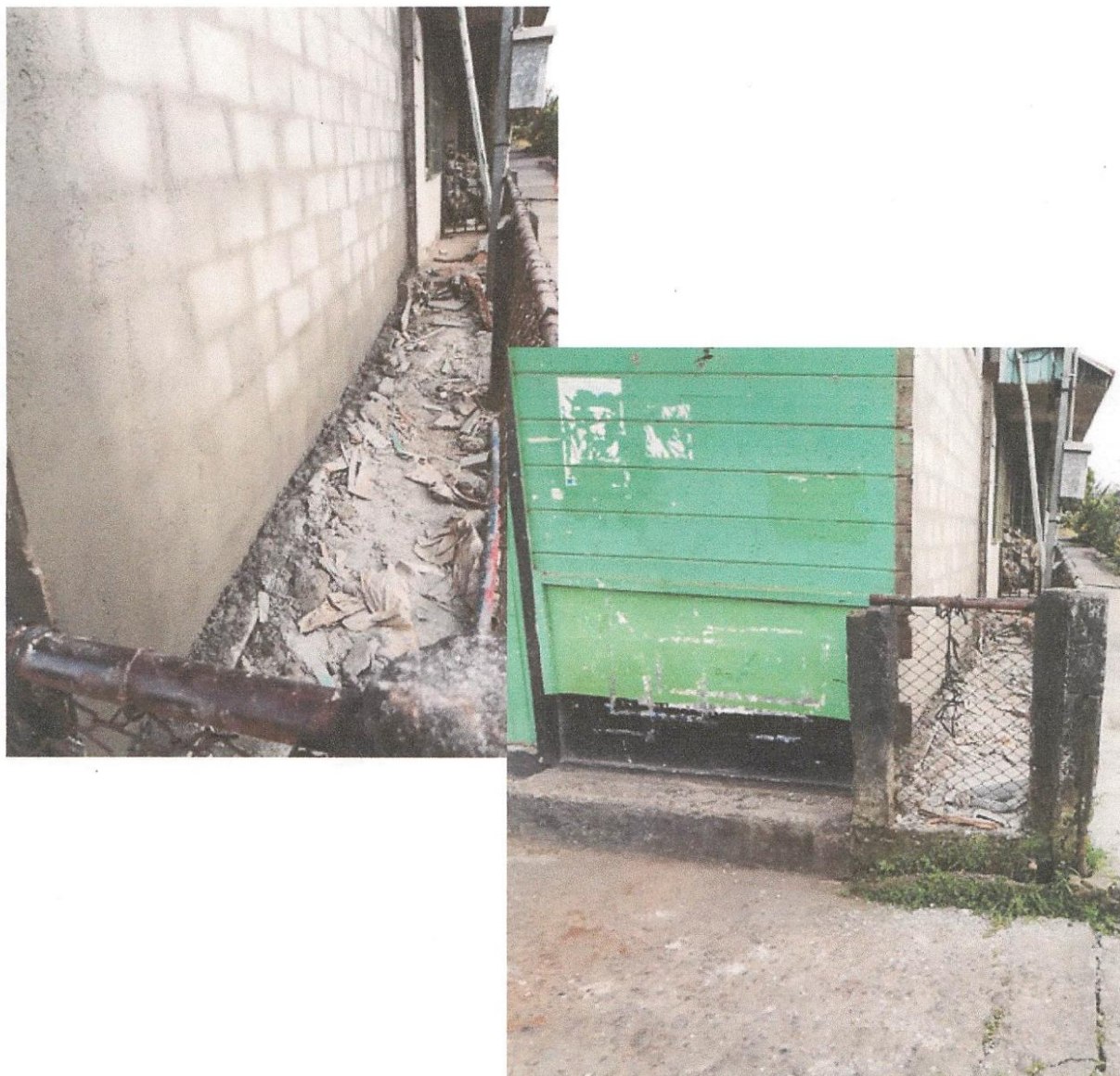
Fotografía #3; escombros, demolición, y construcción de pared costado oeste frente calle publica, sábado 13 de abril
