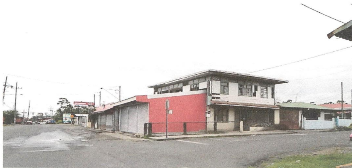
Fotografía #14; edificio remodelado y reconstrucción en el interior del edificio a puerta cerrada en desarrollo diariamente continuo, domingo 21 de abril
