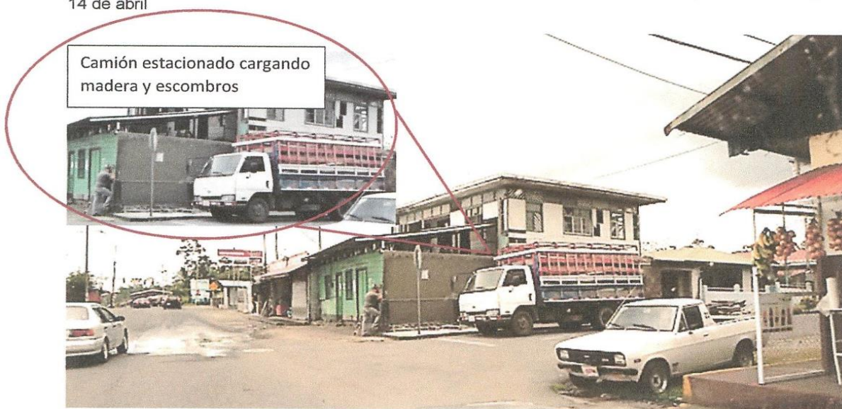
Fotografía #5; Demolición de pared existente, levantamiento de pared nueva, trabajos de repello y transporte de escombros y madera, domingo 14 de abril
