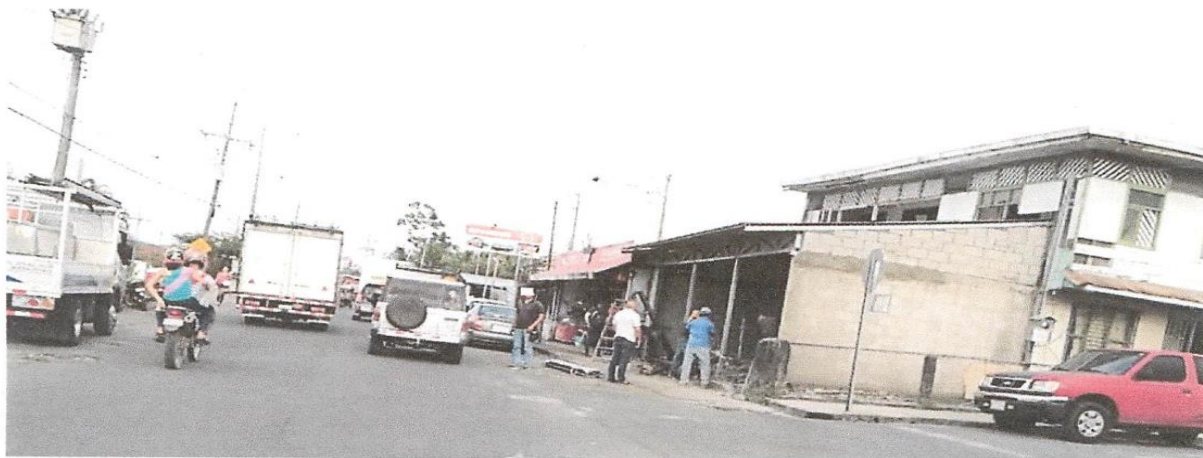
Fotografía #11; demolición y construcción de pared nueva frente calle publica costado norte, jueves 18 de abril (semana Santa | Municipalidad e identidades reguladoras cerradas)
