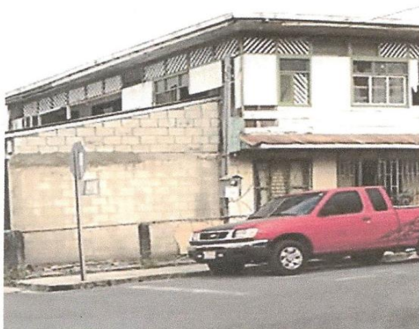
Fotografía #9; pared nueva costado oeste finalizada frente calle publica y finalización de tapichel en block, miércoles 17 de abril (semana Santa | Municipalidad e identidades reguladoras cerradas)
