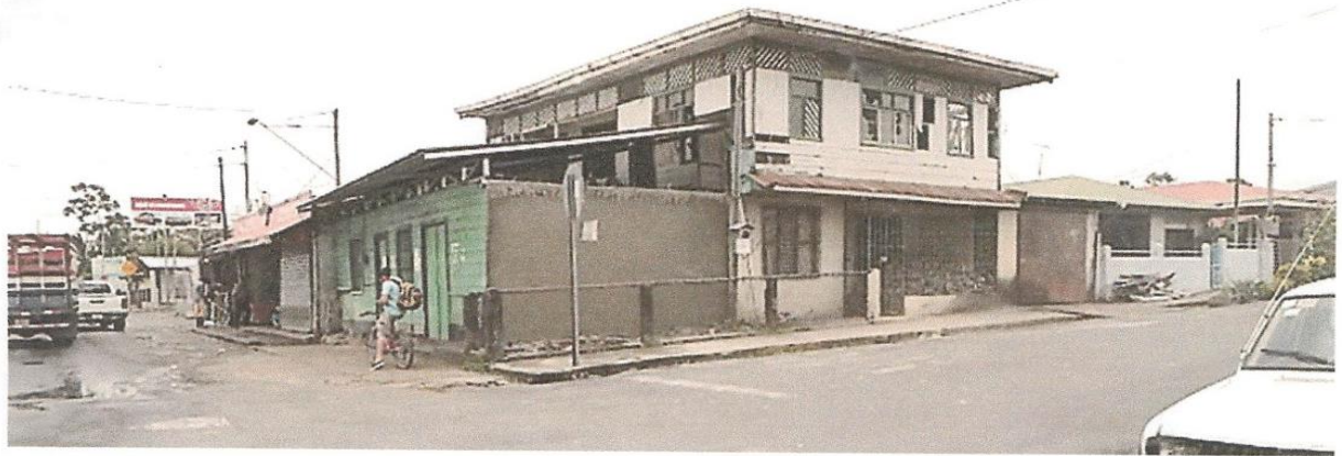
Fotografía #6; Demolición de pared existente, levantamiento de pared nueva, trabajos de repello, domingo 14 de abril
