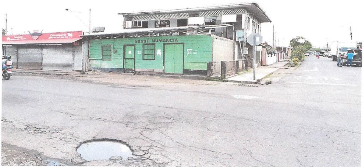
Fotografía #7; pared nueva costado oeste frente calle publica finalizada e inicio de cambio de cubierta y estructura de techo, lunes 15 de abril (semana Santa | Municipalidad e identidades reguladoras cerradas)
