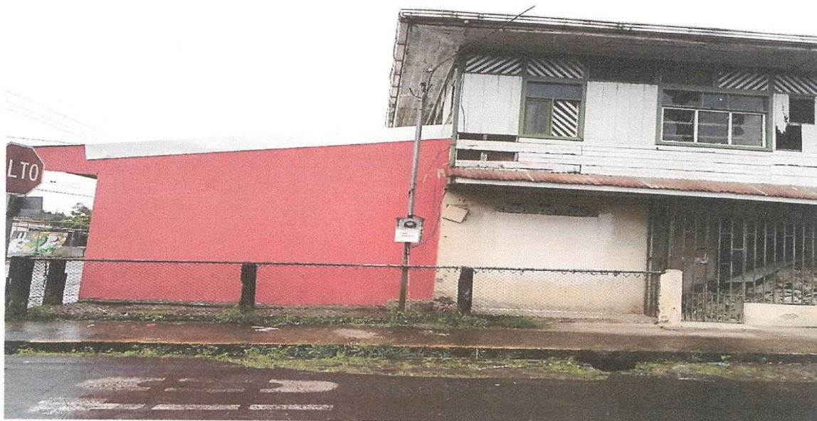
Fotografía #16; finalización de ventana costado oeste y reconstrucción en el interior del edificio a puerta cerrada continúa en desarrollo, miércoles 01 de mayo
