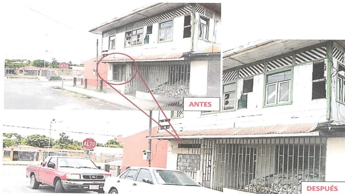
Fotografía #15; cierre de ventana costado oeste y reconstrucción en el interior del edificio a puerta cerrada continua, jueves 25 de abril
