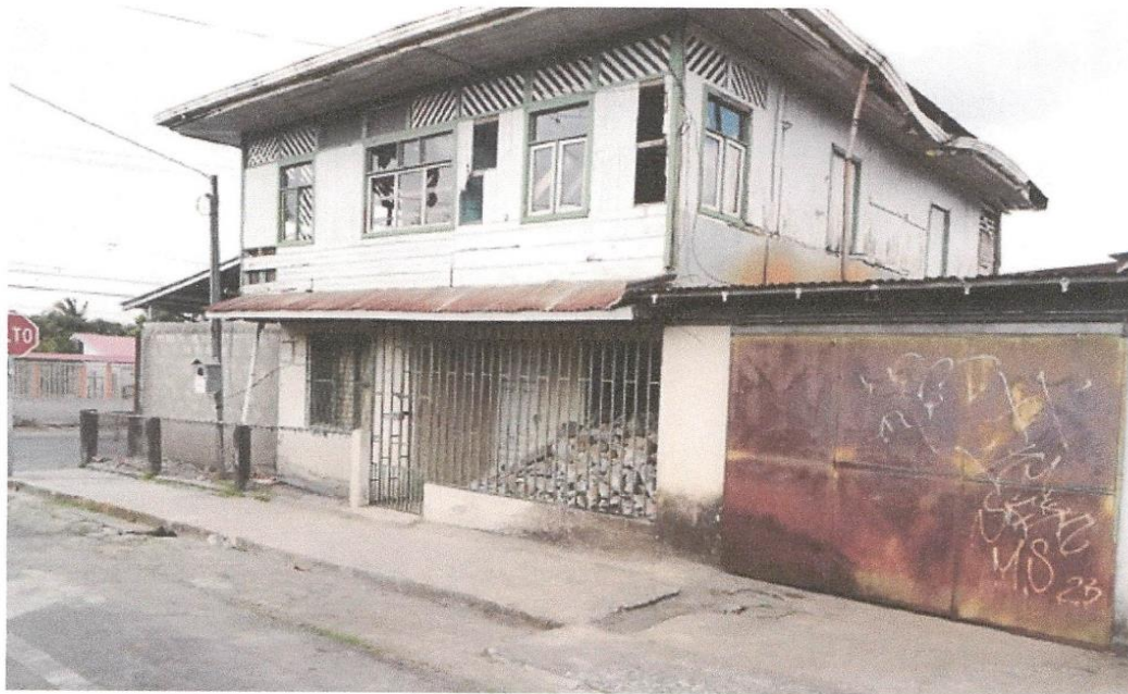
Fotografía #4; Demolición de pared existente, levantamiento de pared nueva, trabajos de repello, domingo 14 de abril
