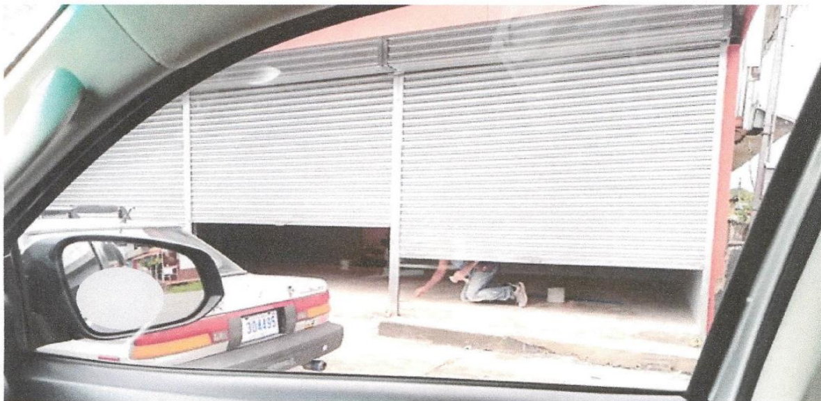
Fotografía #17; chorrea de piso, pega de cerámica y fraguado en el interior del edificio. Reconstrucción en el interior del edificio a puerta cerrada continúa en desarrollo, sábado 04 de mayo
