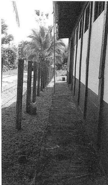
Cerca actual y proximidad de la calle lastrada con las instalaciones
