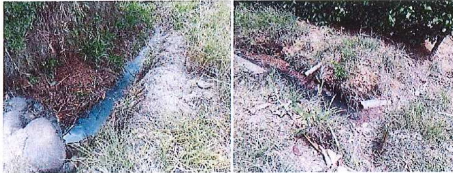
Fotografías 3 y 4. Desfogue de aguas residuales en alcantarillado pluvial.
