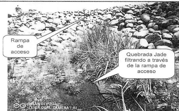
Imagen 2. Taponamiento de la quebrada Jade
