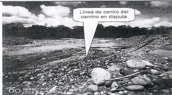
Imagen 3. Extracción de material en zona del camino en disputa.
