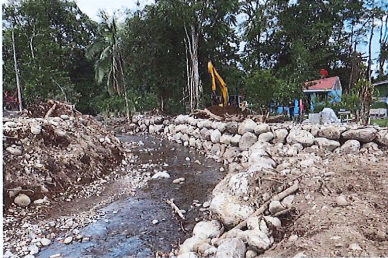
Figura 4.- Trabajos de apilamiento de material y relleno para protección de meandro 2
