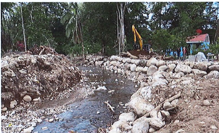
Figura 5.- Trabajos de apilamiento de material y relleno para protección de meandro 2
