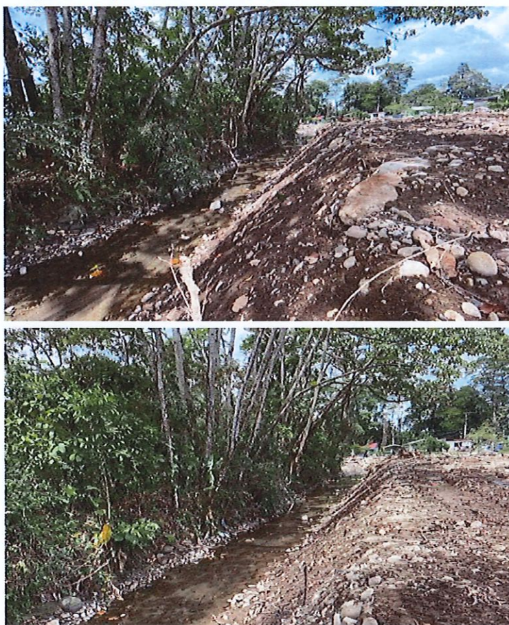
Figura 1.- Trabajos en la sección transversal para aumentar la capacidad hidráulica
