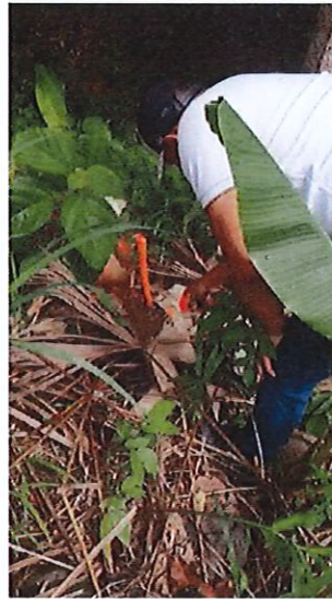
Amojonamiento del resto del derecho de vía
