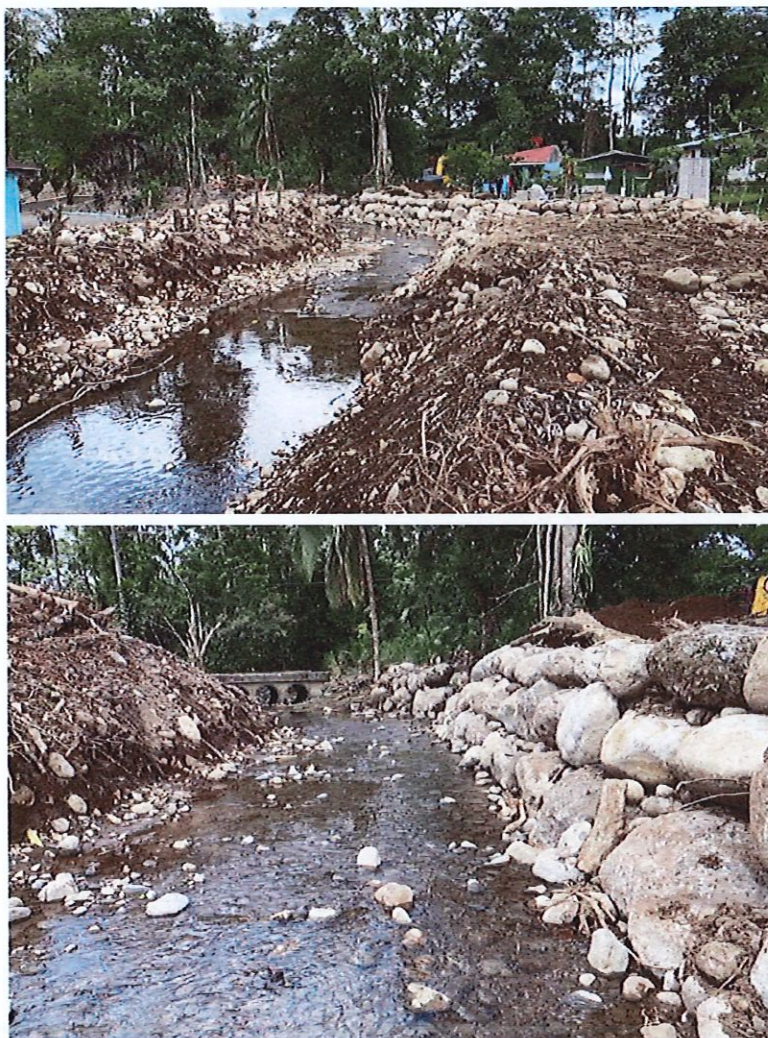
Figura 2.- Trabajos en la sección transversal para aumentar la capacidad hidráulica
