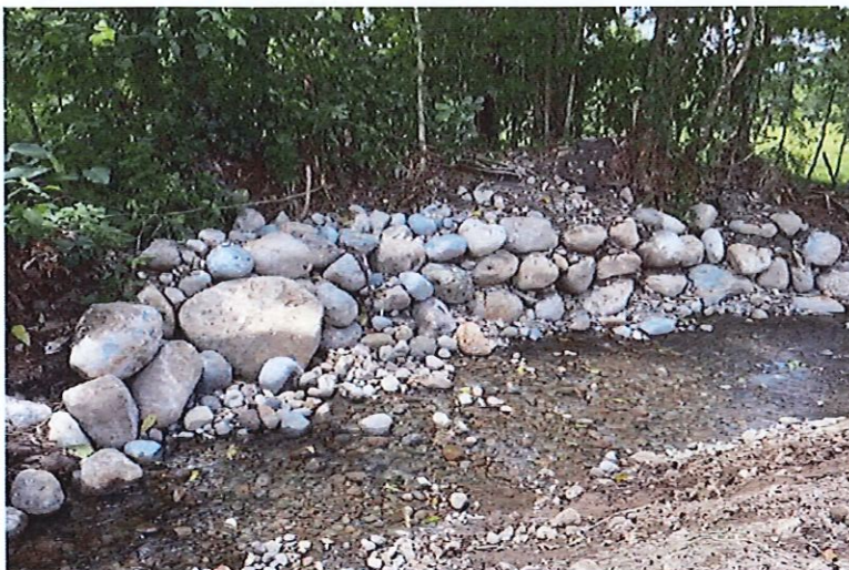
Figura 3.- Trabajos de apilamiento de material y relleno para protección de meandro 1
