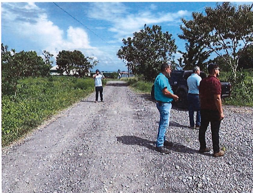
Figura 2.- Condiciones físicas del acceso (servidumbre agrícola) – Tramo A
