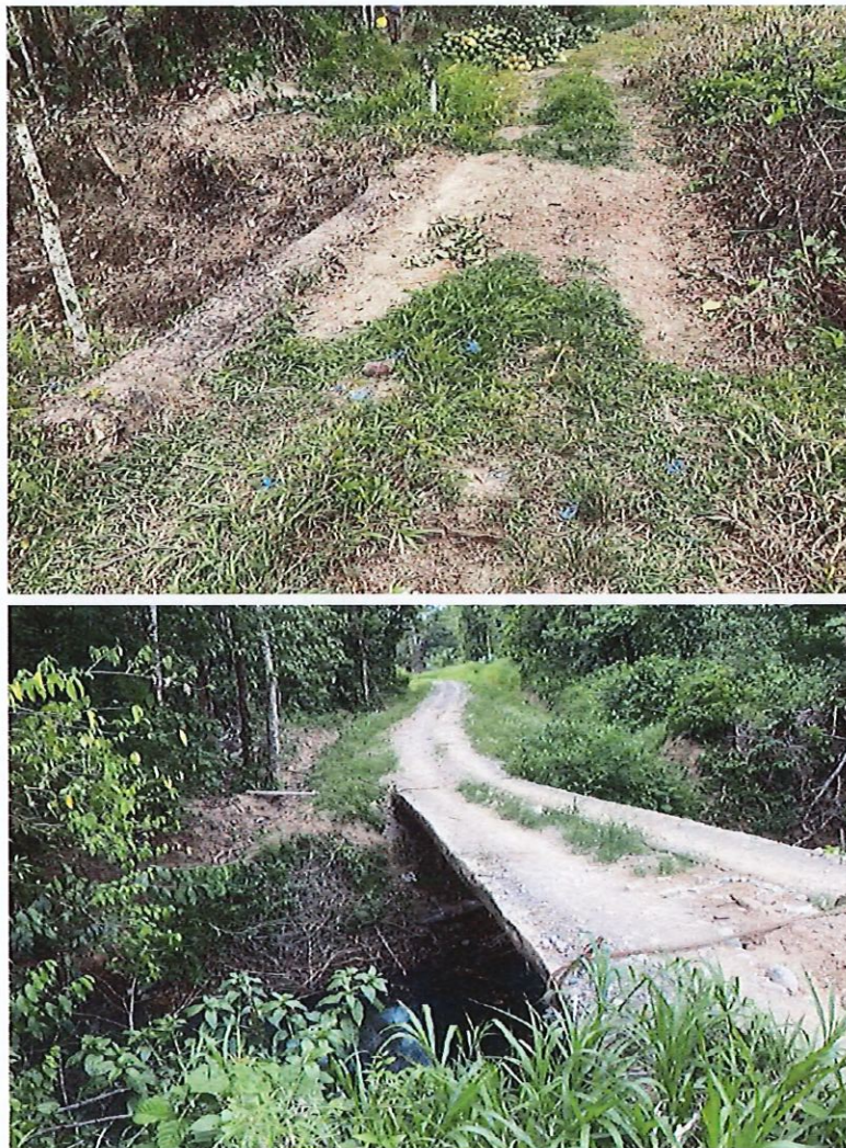
Figura 5.- Condiciones físicas de los accesos
