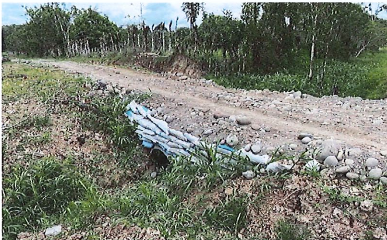
Figura 4.- Condiciones físicas de los accesos
