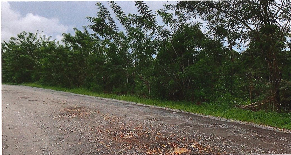
Imagen 5: Estados de las cercas en la inspección de campo.
