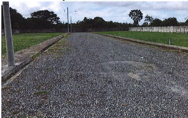
Figura 3.- Condiciones del acceso
