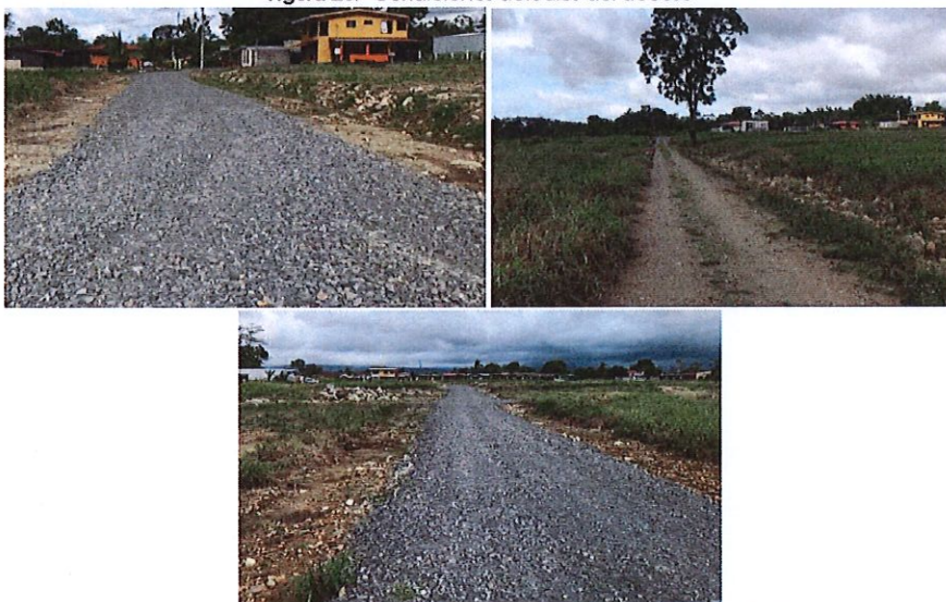
Figura 23.- Condiciones actuales del acceso
