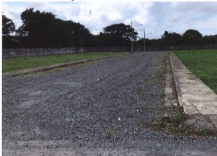
Figura 2.- Condiciones del acceso
