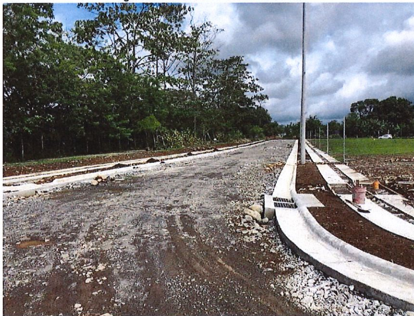
Figura 6.- Condiciones actuales del acceso
