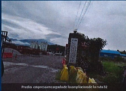
Predio empresa encargada de la ampliación de la ruta 32
