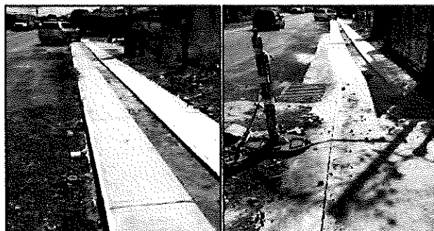
Imagen. Trabajos aceras Cariari Centro
