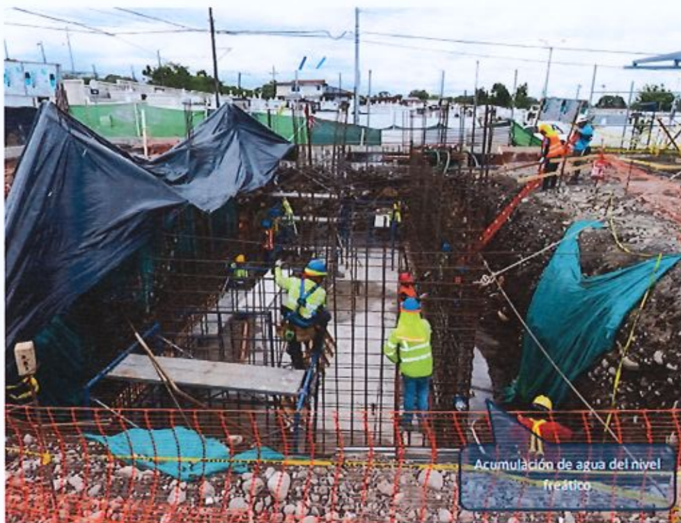
Imagen #2. Excavación fosa de retardo de aguas pluviales.
