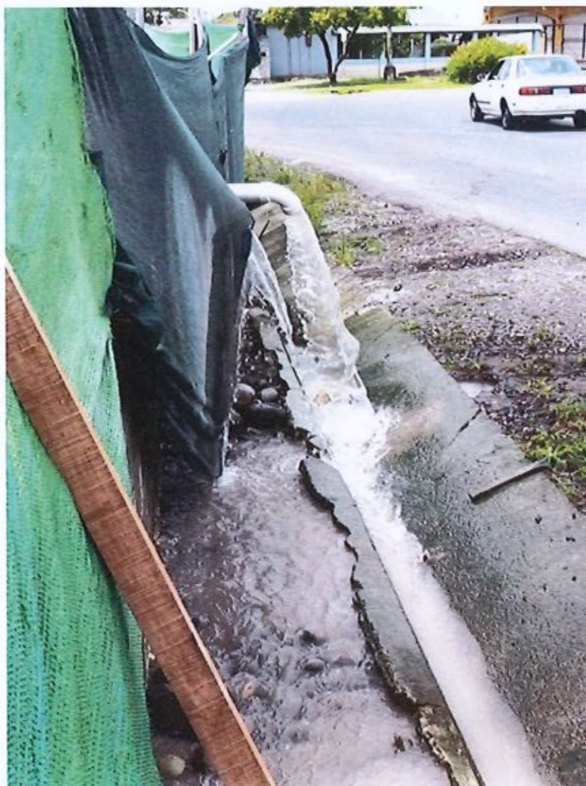
Imagen #6. Descarga de agua a cordón de caño.
