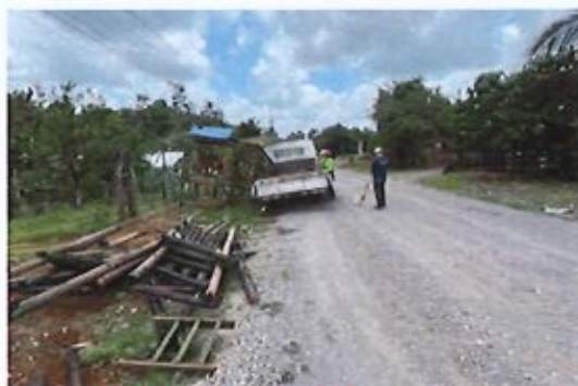
Imagen 3: Colocación de escombros en vía pública
