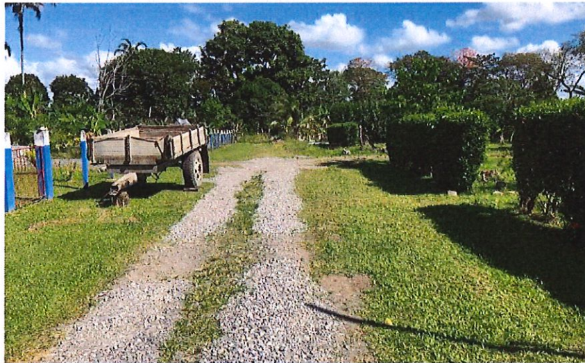
Fotografía 1.- Estado actual de la superficie de rodamiento
