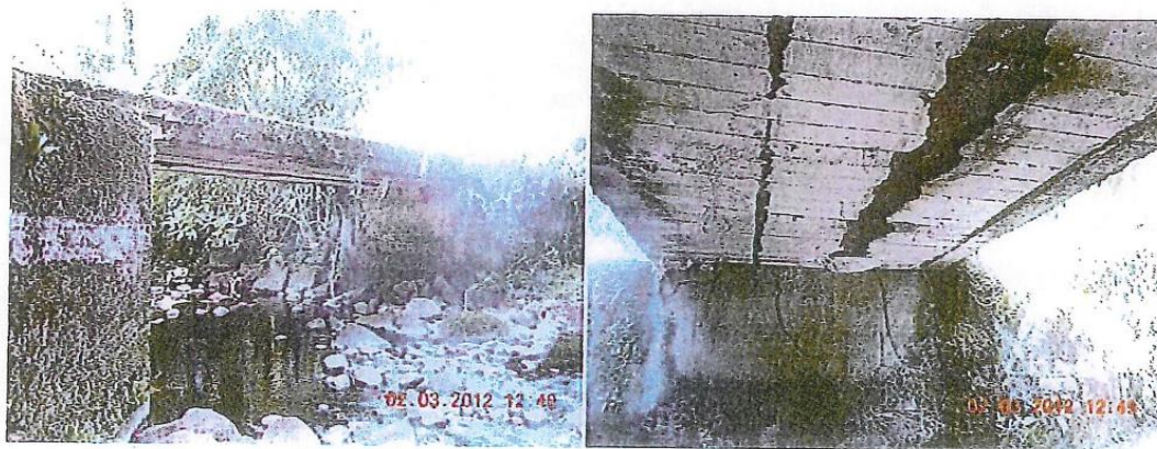
Figura 11: Puente en ruta alterna a Bella Vista Fuente: Visita Inspección LanammeUCR 3-2-12
