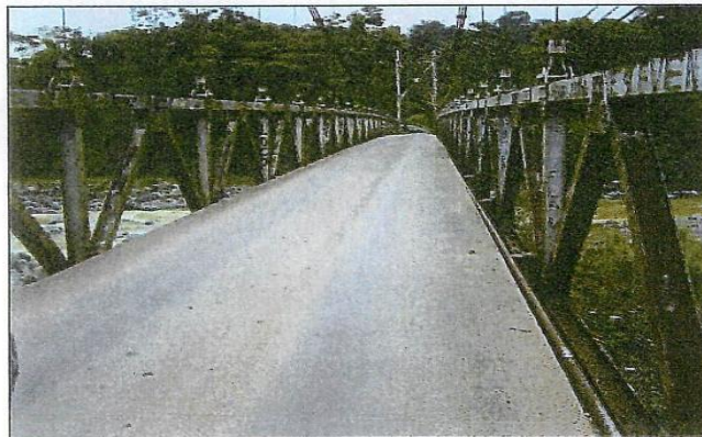
Figura 20. Vigas de rigidez como barandas del puente
