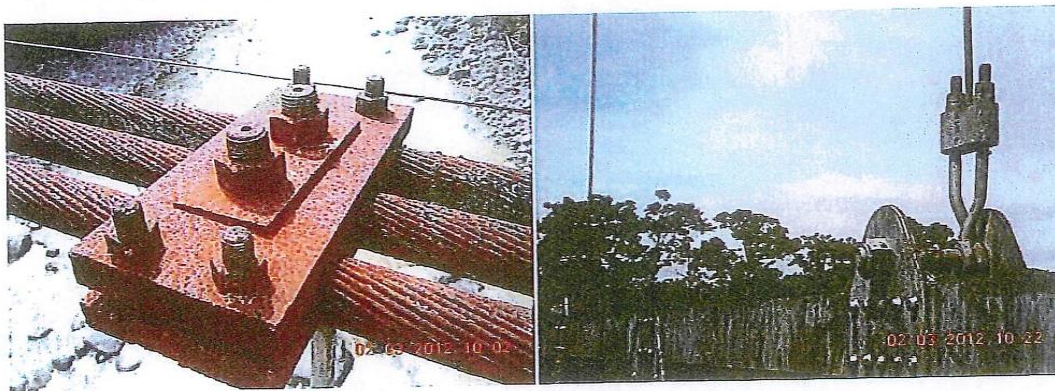
Figura 2: Condición de pendolones
