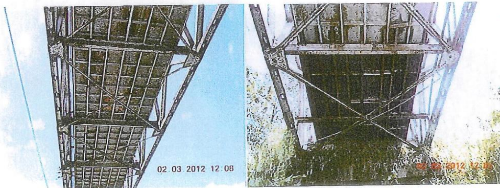
Figura 5: Sistema de piso típico y zona modificada Fuente: Visita Inspección LanammeUCR 3-2-12
