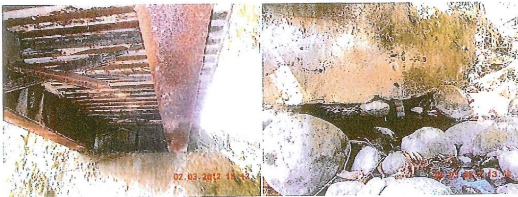
Figura 14: Puente sobre ruta a Bella Vista Fuente: Visita Inspección LanammeUCR 3-2-12
