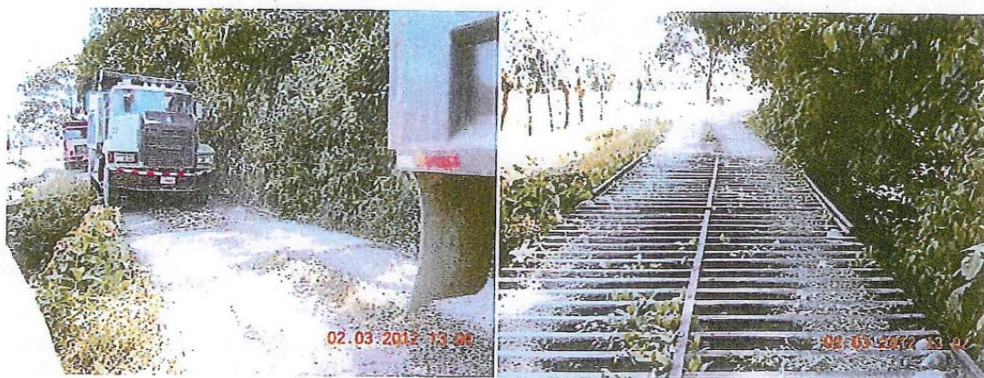
Figura 12: Puente en ruta alterna a Bella Vista Fuente: Visita Inspección LanammeUCR 3-2-12
