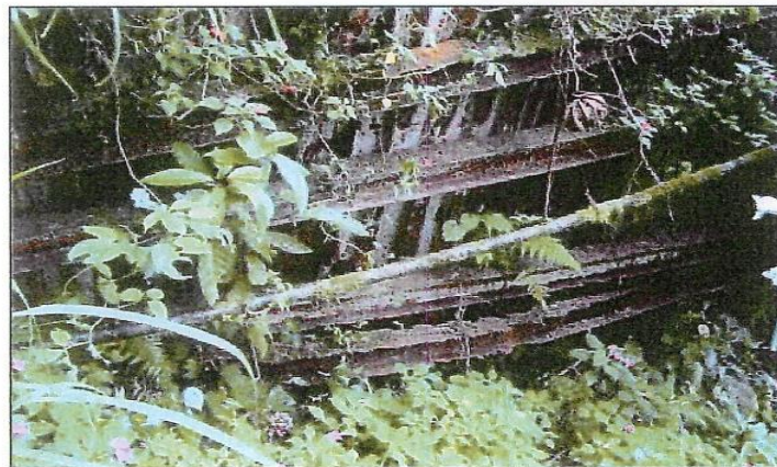
Figura 23. Muro de tablaestacas para protección del relleno de aproximación
