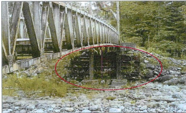
Figura 22. Estado del material del relleno de aproximación
