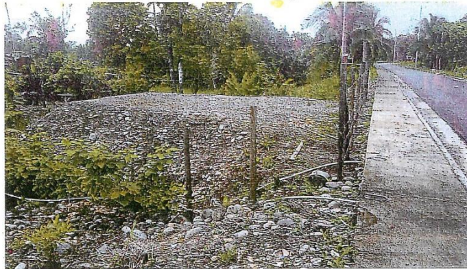
Figura 2.- Rellenos realizados en algunos de los lotes
