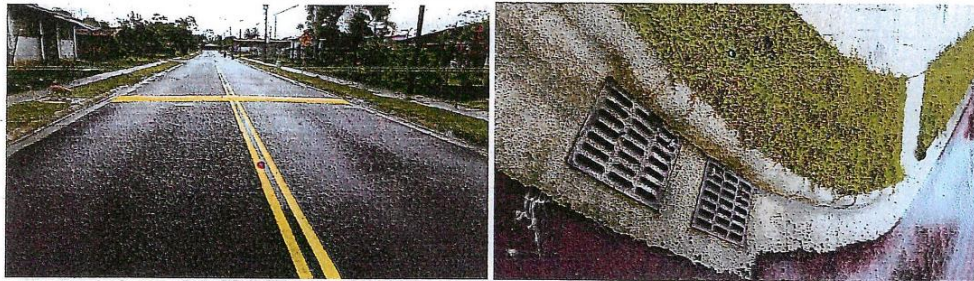
Figura 1.- Infraestructura del Fraccionamiento El Rótulo
