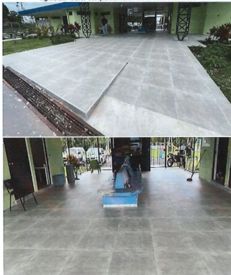
Figura 28.- Obras complementarias en el Centro Acuático
