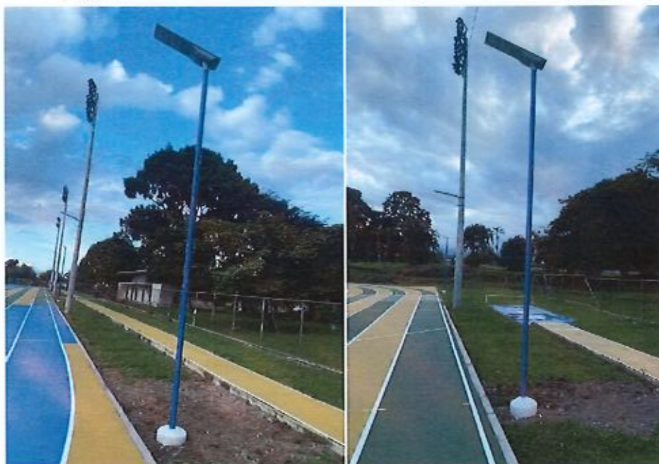
Figura 24.- Proceso de colocación de iluminación complementaria – Pista Atletismo
