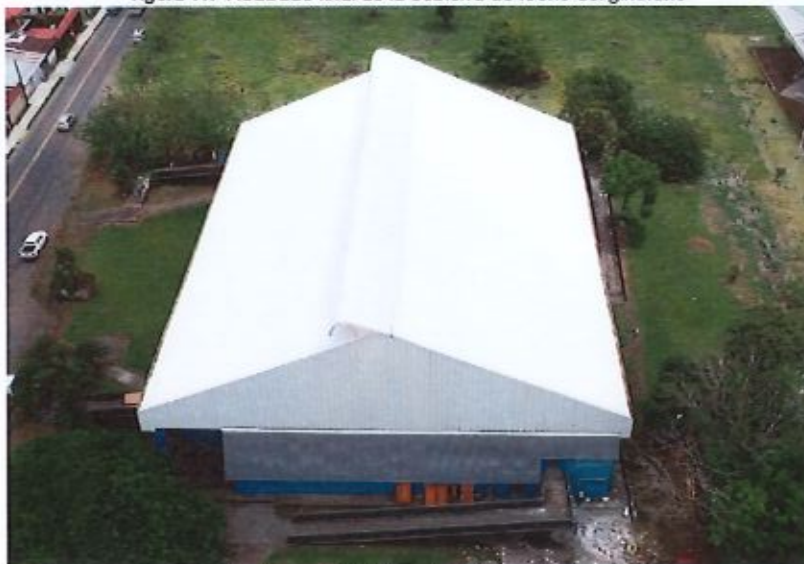
Figura 11.- Acabado final de la cubierta de techo del gimnasio
