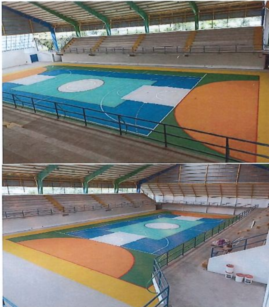
Figura 9.- Acabado final de las instalaciones del Gimnasio
