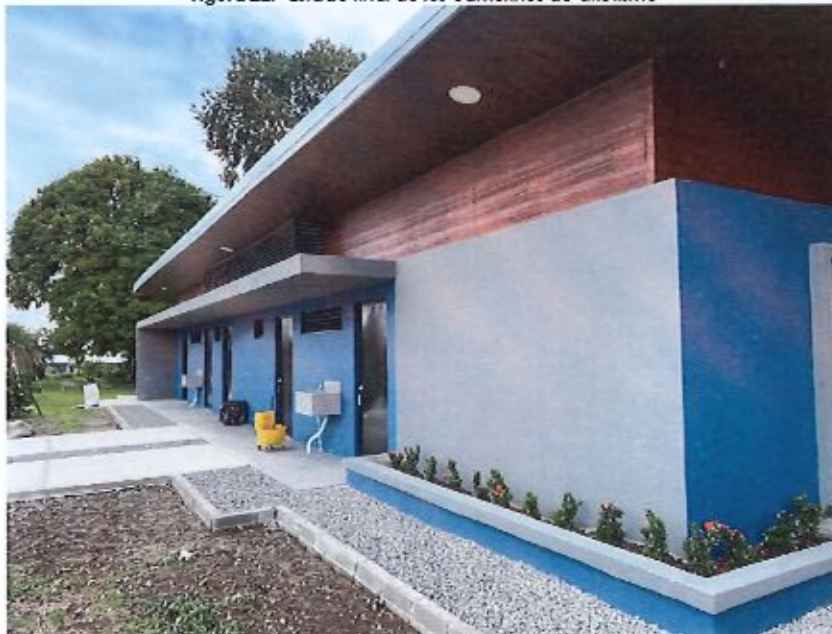
Figura 22.- Estado final de los camerinos de atletismo
