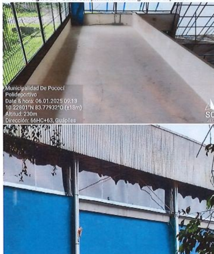
Figura 27.- Obras complementarias del gimnasio deportivo
