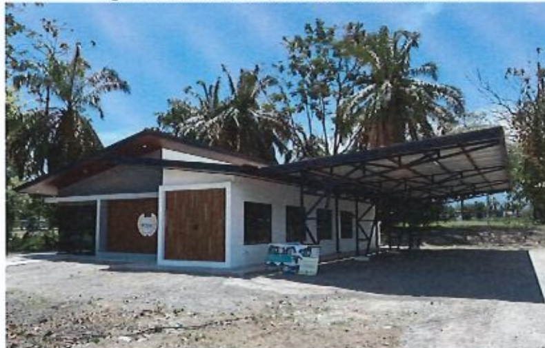
Figura 33.- Estado final de las oficinas del CCDR de Pococi
