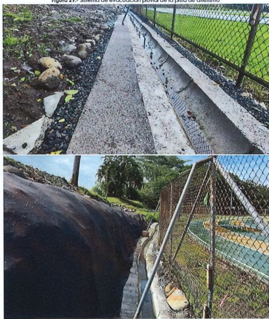
Figura 29.- Sistema de evacuación pluvial de la pista de atletismo
