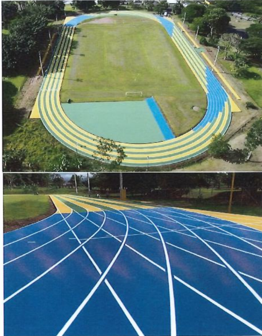
Figura 8.- Acabado final de la pista de atletismo
