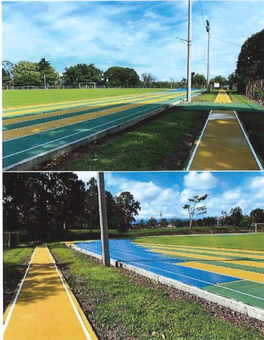
Figura 7.- Acabado final de la pista de atletismo
