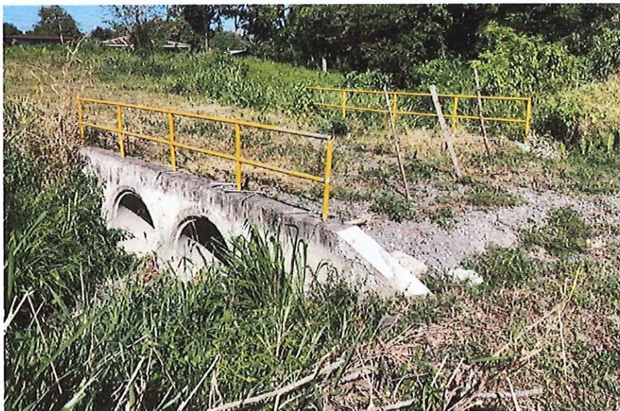
Fotografía 2.- Estado actual del paso de alcantarilla, estación 0+060
