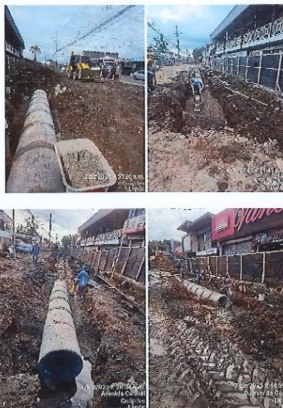
Fotos. Excavaciones e instalación sistema pluvial sección 5.1. El Zócalo
