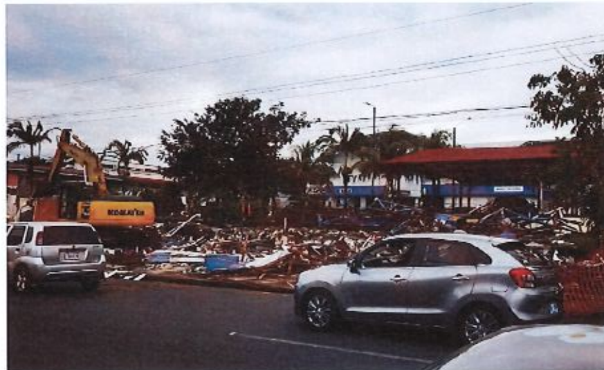
Foto. Proceso de demolición de locales.
