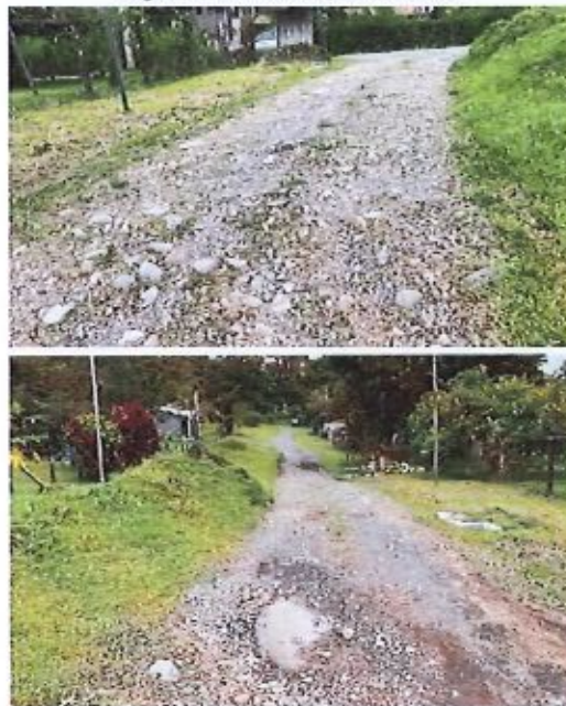
Fotografía 1.- Estado actual de la superficie de rodadura
