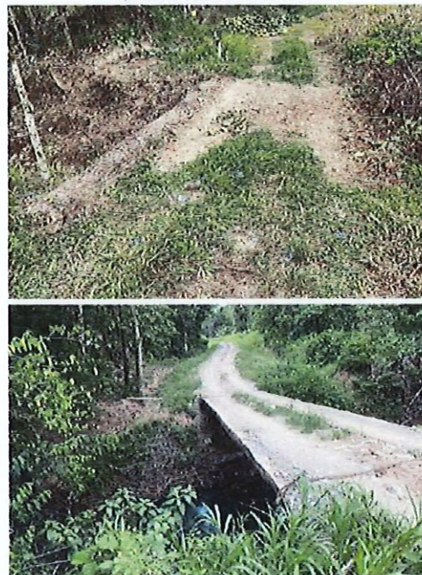
Figura 5.- Condiciones físicas de los accesos
