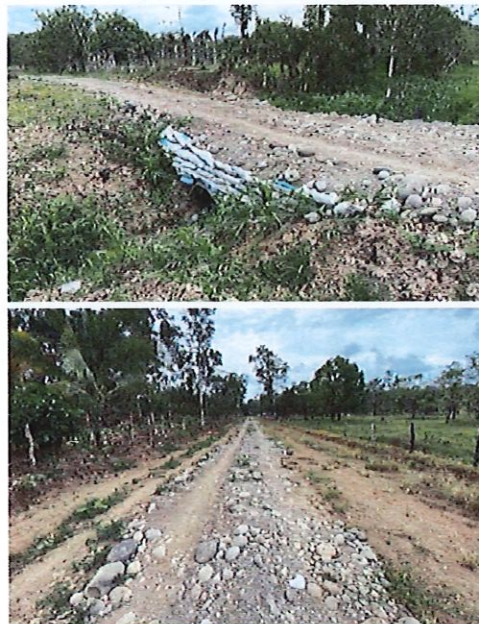
Figura 4.- Condiciones físicas de los accesos
