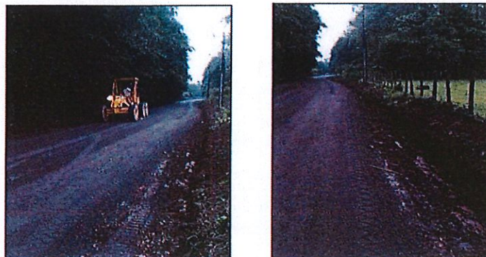
Figura 9 y 10. Mantenimiento rutinario de la ruta
