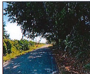
Figura 4. Estado actual del camino
