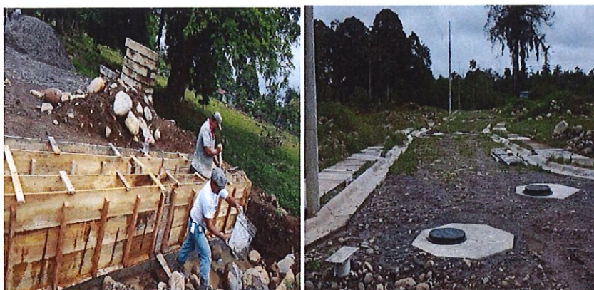
Figura 22.- Obras de infraestructura – Urbanización El Ángel, Guápiles
