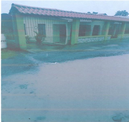
En esta parte de la calle a los lados hay que estar haciendo un caño improvisado cada vez que llueve para poder drenar el agua. Afectando también terrenos ajenos.
