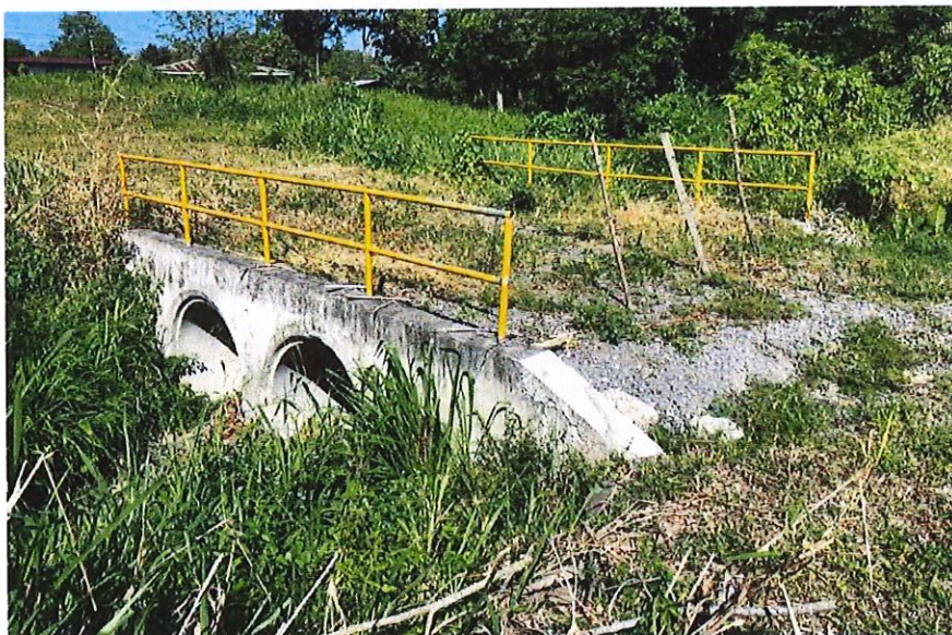
Fotografía 2.- Estado actual del paso de alcantarilla, estación 0+060
