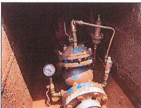
Figura 10. Válvula reguladora de presión de 4" al sur de calle El Manú.
