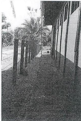
Cerca actual y proximidad de la calle lastrada con las instalaciones
