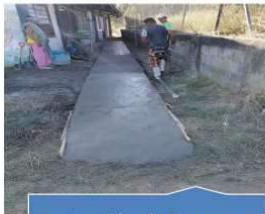
construcción de Aceras para el acceso dentro de la Isla
