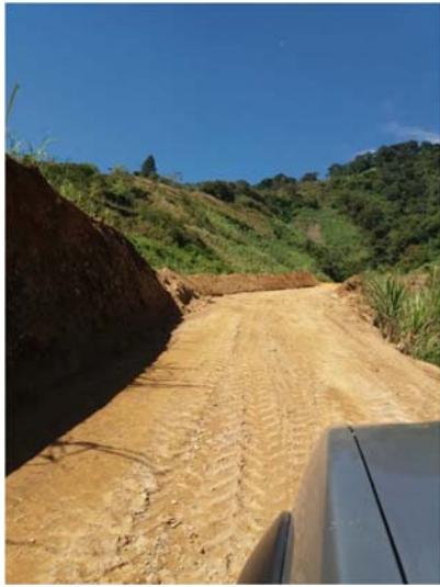
Reparación de la superficie de ruedo del puente Máquina Vieja, en la Esperanza de Pejibaye
