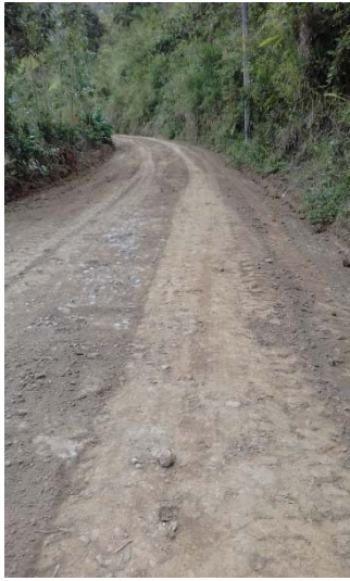
Limpieza mecanizada Camino La Lucha-San Francisco
