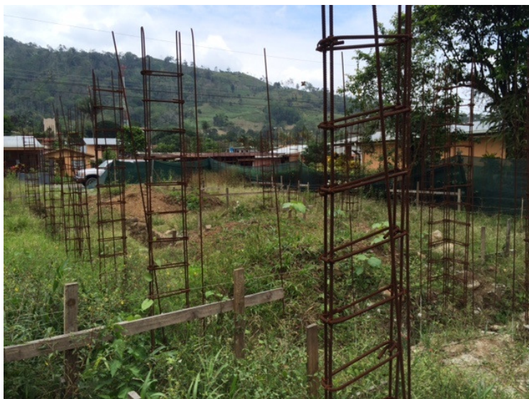
24 25 Armaduras de columnas
