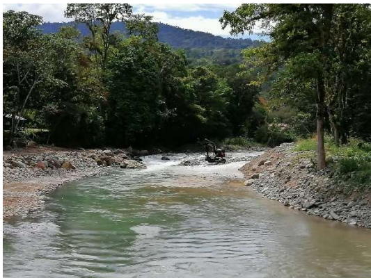
Trabajos en el cauce
