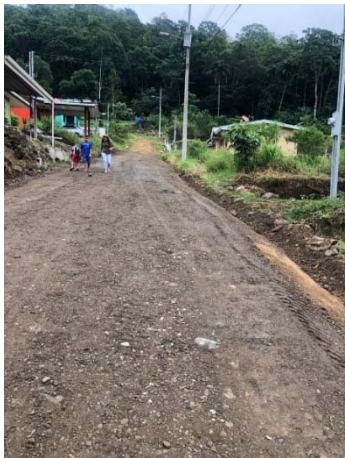
Rehabilitación superficie de ruedo camino El Oso-Oriente
