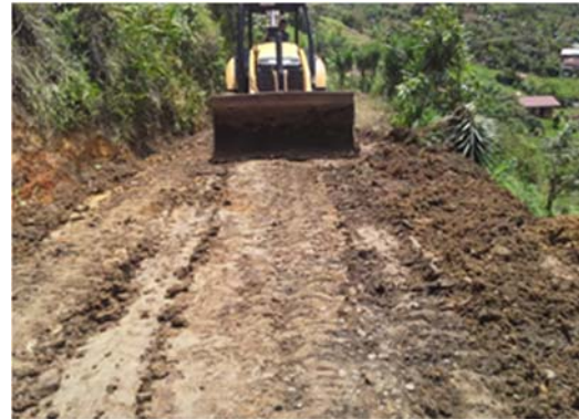
Actividades Realizadas Se realiza remoción de derrumbes menores en los caminos La Marta, Taus y San Martín, todos del distrito de Pejibaye.
