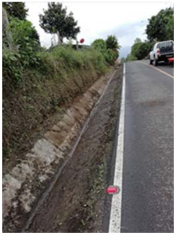
Limpieza manual acera a Naranjo
