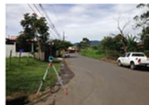
Levantamiento de calle y sifonaje de pluvial, Las Castañas, El Guarco.
