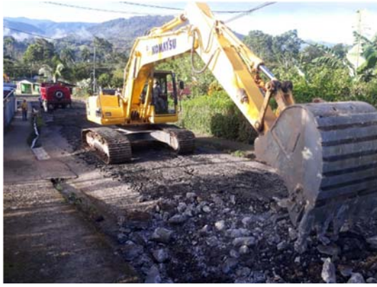
Asfaltado Calles Urbanas Pejibaye Centro Pejibaye
