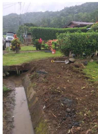
Reconstrucción de caños de concreto Actividades Realizadas en San Martín
