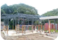
Construcción obra nueva
