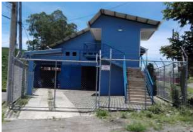
23 Fotografía 3. Centro de Recuperación de Residuos Valorizables de la Municipalidad de 24 Jiménez.
