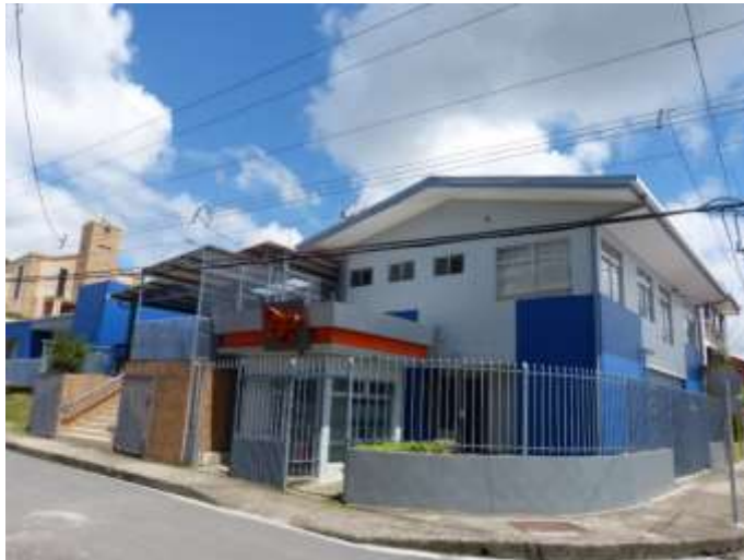
Fotografía 1. Edificio principal de la Municipalidad de Jiménez.
