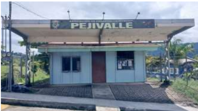
Fotografía 5. Oficina de servicios municipales, ubicada en Pejivalle Centro.
