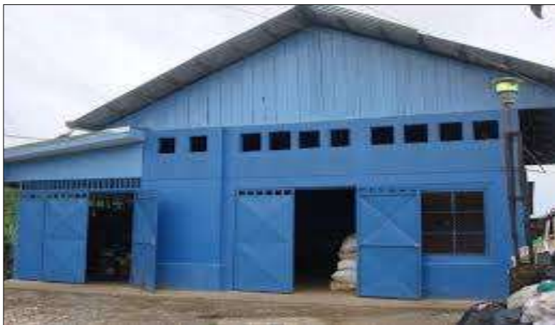
Figura 4. Centro de Recuperación de Residuos Valorizables (CRRV) del cantón de Jiménez.
