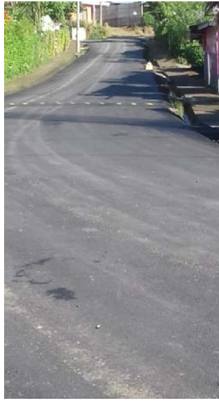
Actividades Realizadas 1- Se realizan los trabajos de construcción de cunetas de concreto en los alrededores de la cancha multiusos de Barrio San Antonio de Pejibaye, junto con la sustitución de un paso de alcantarilla dañado en el sector. Además, se realiza la colocación de una carpeta asfáltica en los cuadrantes urbanos de San Antonio.
