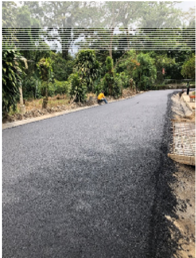
Proyecto Recarpeteo, Cuadrantes Urbanos
