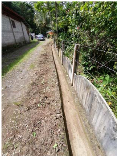
Limpieza de cunetas y caños en cuadrantes y Ruta Nacional 408. Sector Los Tigres.
