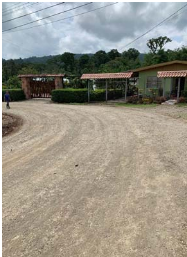
Construcción de Acera entre Actividades Realizadas
