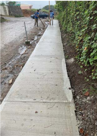
2- Se inicia con los trabajos de construcción de la acera (chorrea de la losa de concreto)
