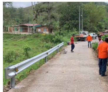
Puente sobre Rio Gato (Flex beam)
