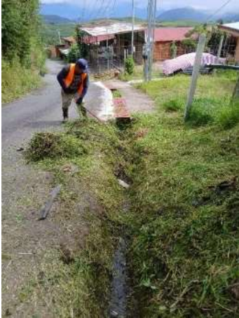
Quebrada Honda Limpieza y pintura de puentes
