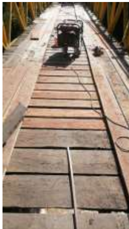
Sustitución de tablonos Puente El Congo Pintura de reductores de velocidad
