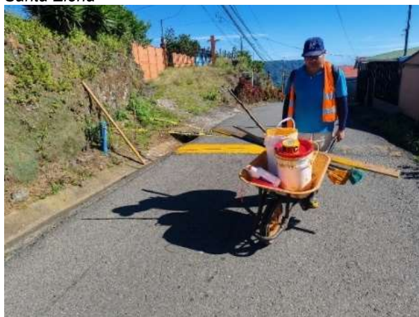
Pintura reductores de velocidad
