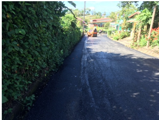
I Etapa Asfaltado Camino El Ingenio, Juan Viñas
