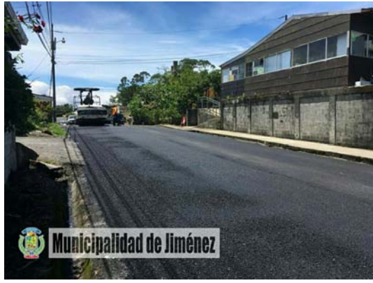
Proyecto Asfaltado Cuadrantes Urbanos Los Jovitos Juan Viñas
