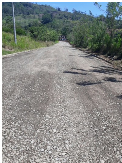
Camino La Ponciana-Aeropuerto Plaza Vieja de Pejibaye
