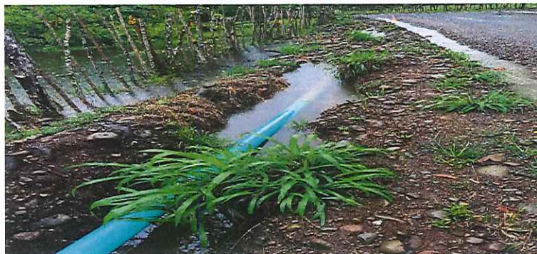
Figure 14Continuidad del entubado
