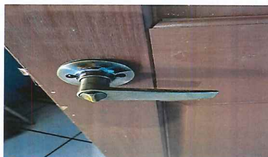
Figure 3 Puerta de pino y cerrajería tipo manija
