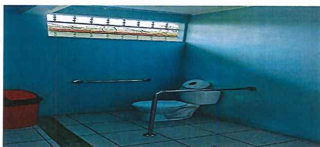
Figure 2 Barras de seguridad y enchape del piso
