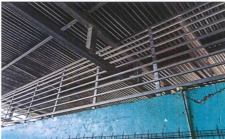
Figure 11 Construcción de malla separadora para seguridad
