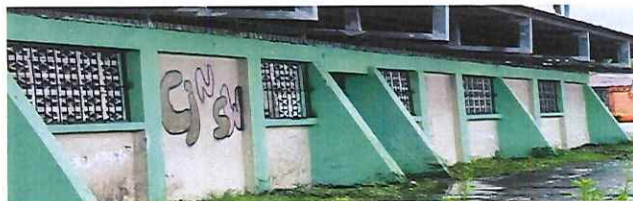
Figure 4 Puesta de verjas para seguridad
