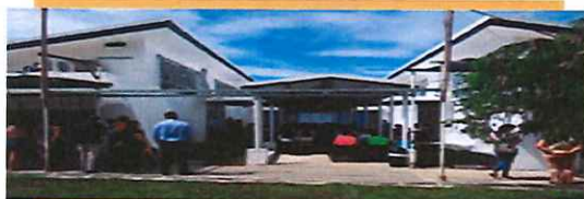
Foto No 3. Módulo Nuevo de Aulas del Recinto de Guápiles
