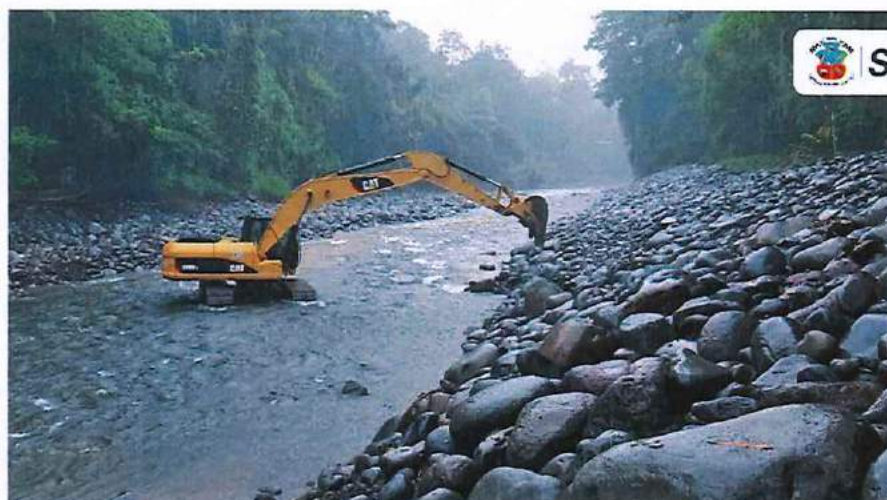
Conformación de 614 m de Dique en Río Das Novillas
