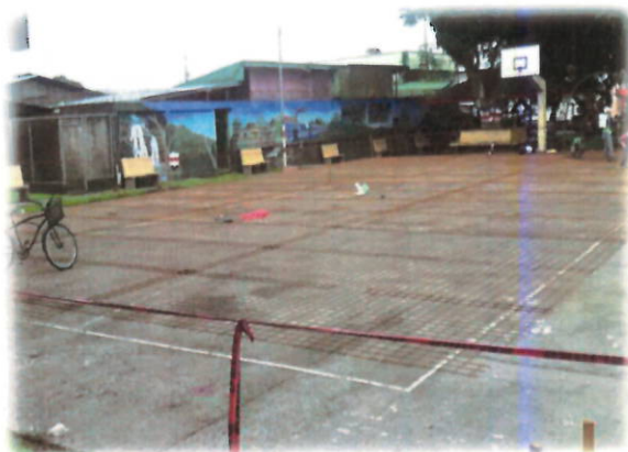
Imagen 1 reconstrucción de superficie
